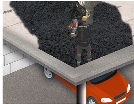
Trennlage mit Überdeckung verlegen
