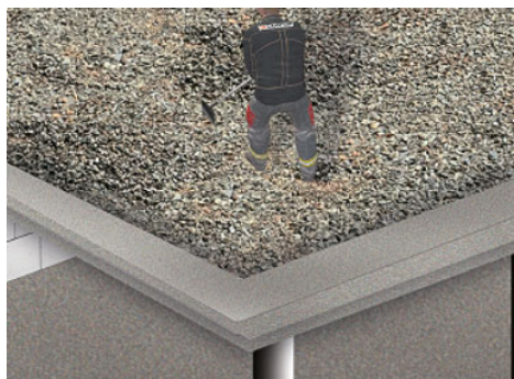
Kies/Splittbett für Pflasterbelag herstellen
