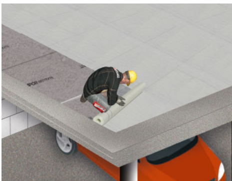
ggf. Glasgittergelege über Geotextil verlegen
